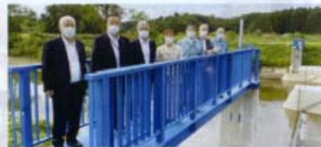
築造後概ね50年経過した、大善寺地区頭首工改修工事により受益地へ安定した農業用水を確保する。
